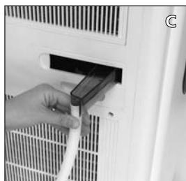
**1** Die Ableitungsrinne **8** aus dem Gerät ziehen.
