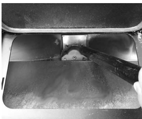
Fig. 22 - Pulizia serbatoio e codea
