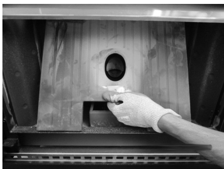
Fig. 34 - Rimozione ghisa centrale
