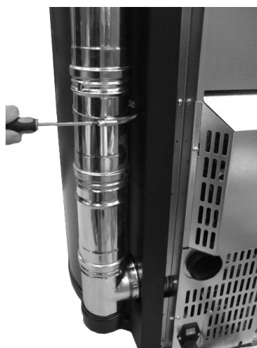
Fig. 103 - Canale da fumo (Sfera³ Plus, Sfera³, Globe, Elise³ Plus)
