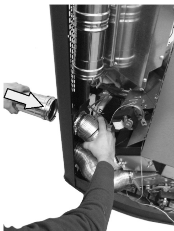
Fig. 66 - Posizionamento tubi per canalizzazione
