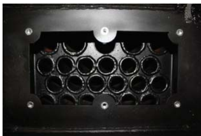
PARTICOLARE DEL FASCIO TUBIERO
