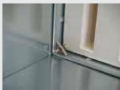
Speciale telaio di montaggio con meccanismo di calettamento per il filtro, per un'installazione a tenuta del filtro e possibilità di revisione ottimizzata.
