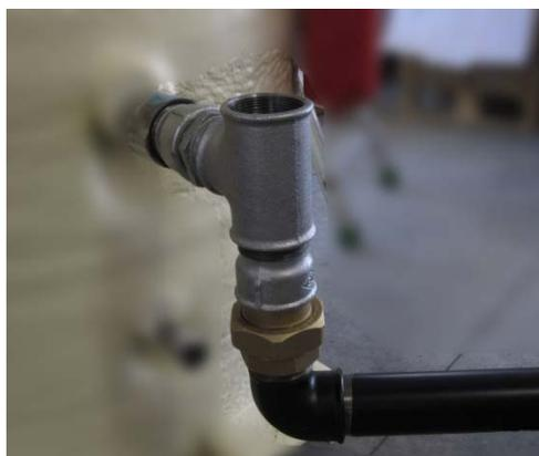
Collegare la tubazione 2" al TEE 2" sul ritorno dell'HM201 attraverso la riduzione MF 2" ed il bocchettone MF 2" in dotazione.
