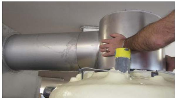
Installare il raccordo camino innestandolo nel raccordo camino del recuperatore e sopra la guarnizione. Inserire le apposite viti per il fissaggio del camino.
