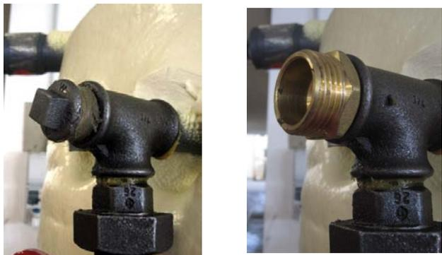
Smontare i due tappi sui TEE collegati ai vasi di espansione e sostituirli con la riduzione  $\frac{3}{4}$ "-1" in dotazione.
