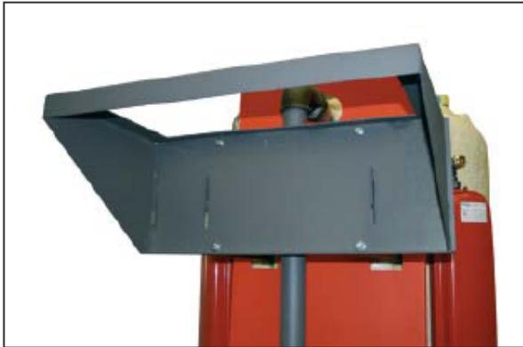
Fissare il supporto del recuperatore alle due staffe montate in precedenza con N. 4 viti M10 in dotazione.
