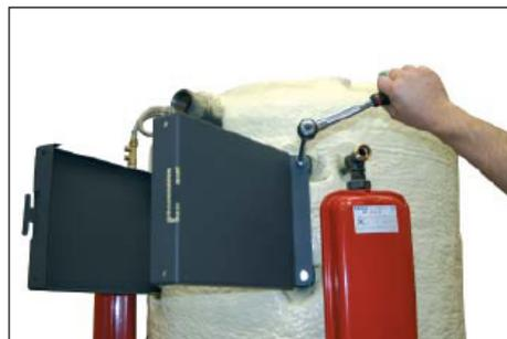
Fissare le due staffe di supporto del Booster sugli appositi ancoraggi situati nella parte posteriore dell'HM 201 con N. 4 viti M10 e rondelle in dotazione.
