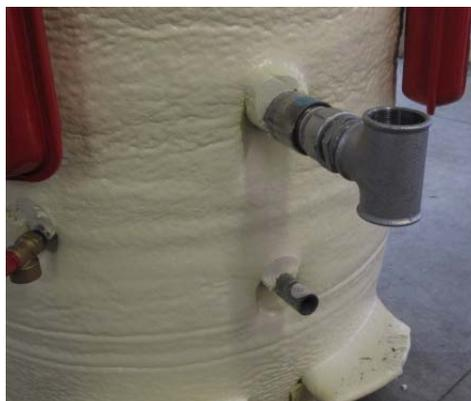
Avvitare il TEE 2" sul raccordo inferiore ritorno riscaldamento dell'HM201.
