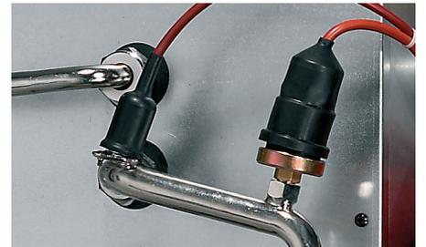
Il pressostato acqua è un dispositivo supplementare che consente, in mancanza di pressione, di mandare la caldaia in blocco ed evitare quindi il funzionamento dello scambiatore a "secco".
