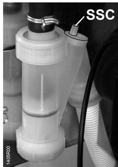
**⚠** **Controllare la tenuta del sifone, verificando che entrambi i tappi (superiore ed inferiore) siano correttamente e completamente avvitati.**
