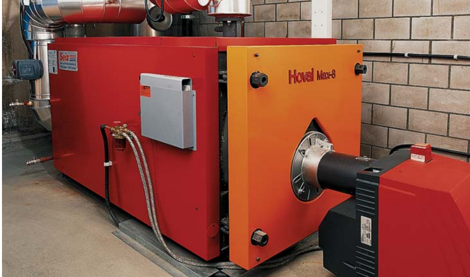
Esempio di un impianto di riscaldamento Hoval Max-3
