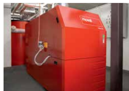
Ideale per spazi ristretti: riqualificazione dell'impianto di riscaldamento con UltraOil®(110) in una casa plurifamiliare a Feldkirch (AT).
