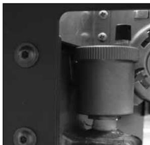
Valvola di sfiato automatica: questa valvola elimina l'aria all'interno della caldaia.
