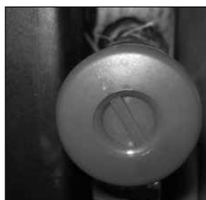
Valvola di sicurezza: questa valvola interviene per prevenire una sovrappressione dell'impianto idraulico.
