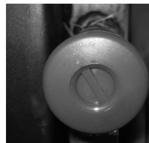
**Valvola di sicurezza:** questa valvola interviene per prevenire una sovrappressione dell'impianto idraulico. Se la pressione della caldaia o dell'impianto supera i 2,5 bar essa scarica l'acqua dal circuito. **Attenzione!** Il costruttore dell'apparecchio non è responsabile per eventuali allagamenti causati dall'intervento della valvola di sicurezza nel caso in cui questa non sia stata correttamente raccordata all'esterno del prodotto ad un idoneo sistema di raccolta ed evacuazione.
