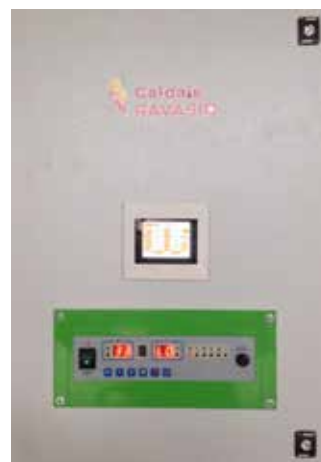
Il quadro elettrico di caldaia può sostituire interamente quello di centrale termica.
