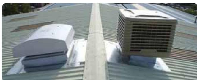
Installazione con uscita inferiore
