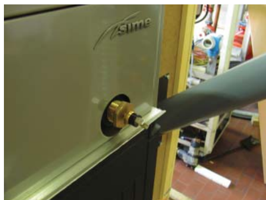
Fig. 28 Termostato di sicurezza
