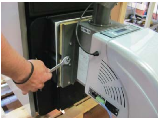
Fig. 25 Montaggio bruciatore
