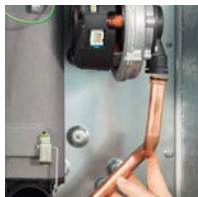
Rimozione del tubo gas
