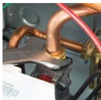
Rimozione del sistema di serraggio della tubazione
