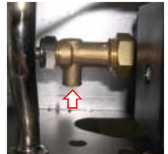
Alkon R Regolazione By-pass
