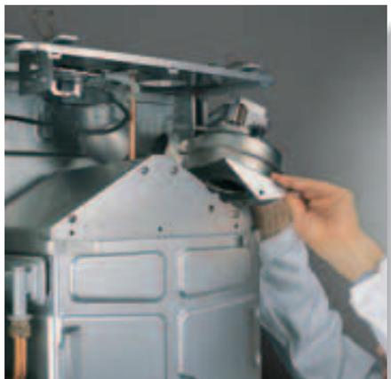
Smontaggio frontale del ventilatore con rimozione di una vite
