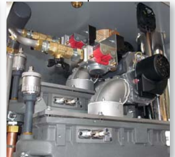
2 Gruppi: ventilatore, valvola gas modulante, bruciatore premix
