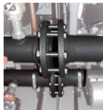
Installazione semplificata (particolare flangia/flangia)
