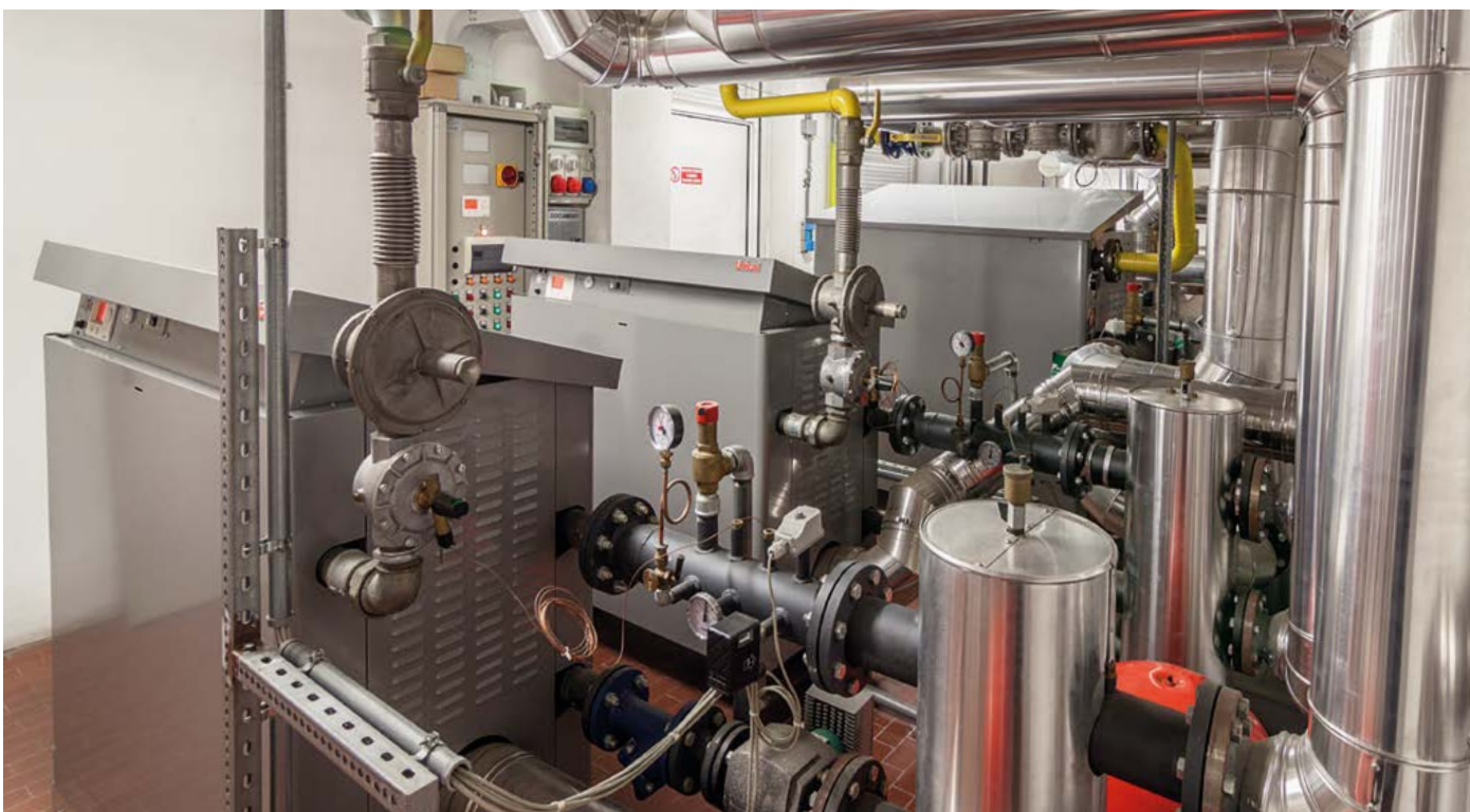
INSTALLAZIONE IN CENTRALE TERMICA
