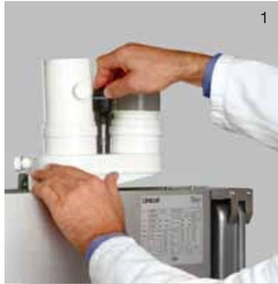
Disposizione sistema di scarico e applicazione dima
