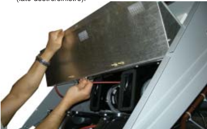
- Rimuovere i tubi in silicone rossi e poi la camera ventilatori
