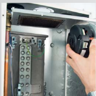
Rimozione del sistema di combustione completo
