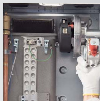
Apertura sistema combustione completo
