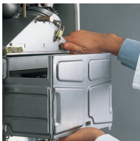
Apertura camera di combustione con leve a scatto
