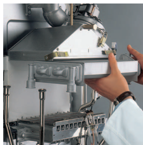
Smontaggio scambiatore a scorrimento frontale con sganci rapidi
