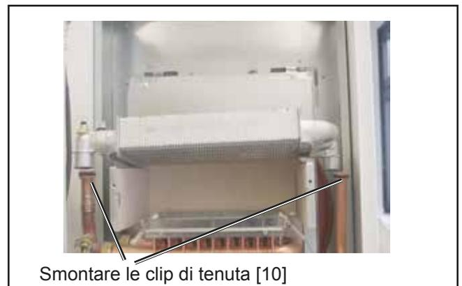
Figura: Smontaggio scambiatore di calore del riscaldamento
