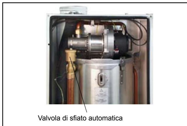
Figura: valvola di sfiato automatica
