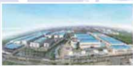
Sito di Ningbo
