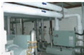
Pompa di calore Water Source di concezione tradizionale installata in una centrale termica
