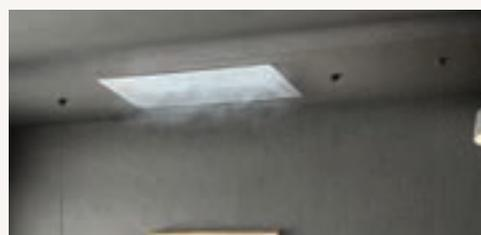
\*135 mm è l'altezza dell'unità fino al pannello dal soffitto. 145 mm è l'altezza compresa il pannello dal soffitto. I modelli fino a 2,5 kW e 3,6 kW (FJM) misurano 135 mm (180 mm pannello incluso).
