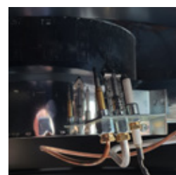
gruppo accensione con fiamma pilota, termocoppia e piezo-elettrico
