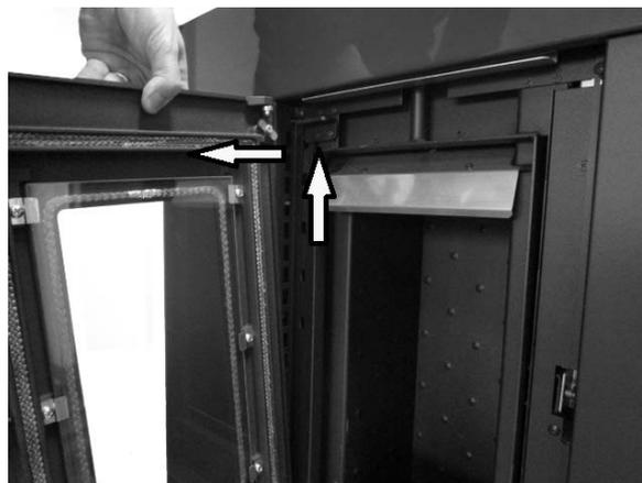
**Fig. 19 - Rimozione porta**
