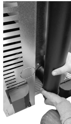
Fig. 44 - Innestare tubo d.80 mm
