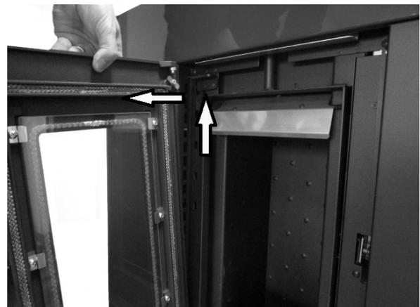
Fig. 18 - Rimozione porta
