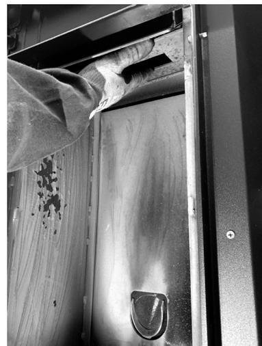
**Fig. 70 - Rimuovere la testa del focolare 1**
