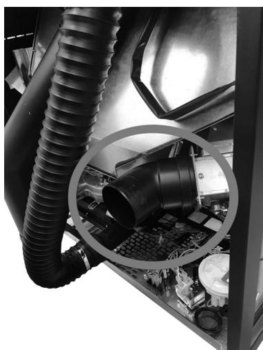
**Fig. 37 - Posizionare raccordo 45°**
