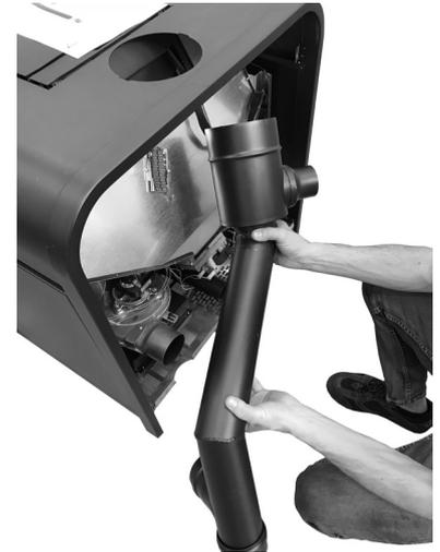
**Fig. 48 - Posizionare tubo scarico fumi + concentrico**
