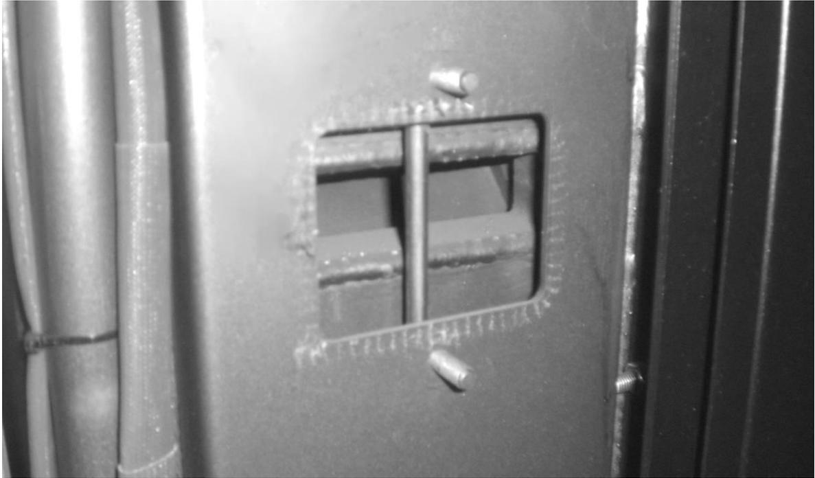
Pulire l'eventuale ostruzione del passaggio fumi laterale e rimontare la bocchetta d'ispezione.
