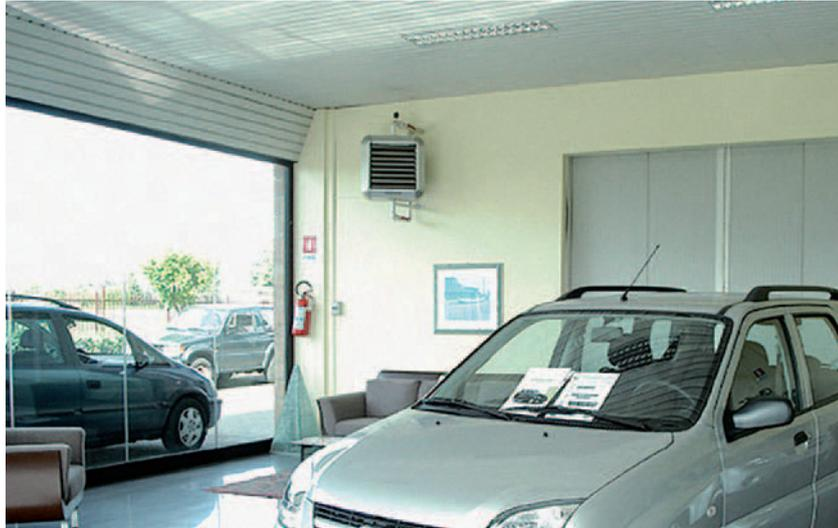
**G**li aerotermini Helios sono prodotti in **6 grandezze** con rese termiche da **5 a 60 kW** e sono disponibili con batteria a 1 rango per impianti a vapore o acqua surriscaldata, a 2 ranghi per impianti ad acqua calda ed a 3 ranghi per impianti ad acqua calda a bassa temperatura. Possono essere installati a parete ed a soffitto.
